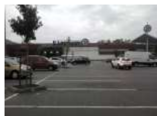
Aucune traversée piétonne depuis parking Leclerc Issenheim
